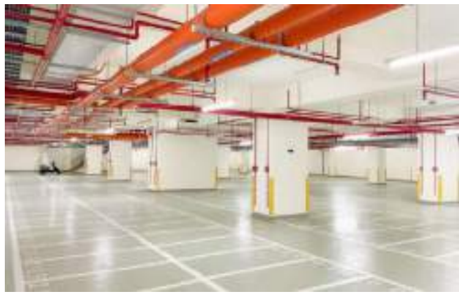
室內停車場 ( 為你的愛車遮風擋雨 )
